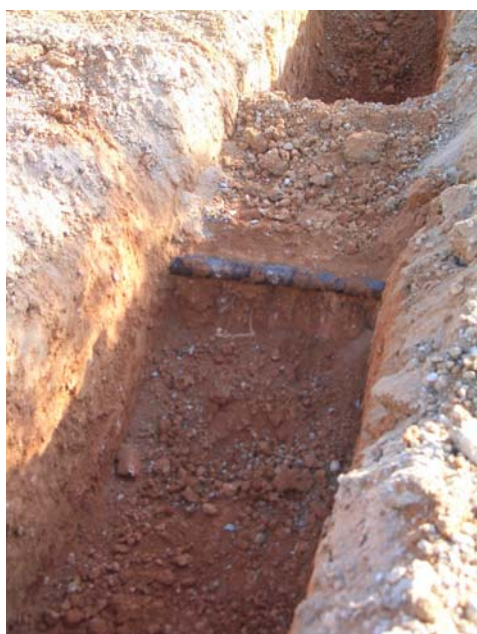
Canonada U.E.217 en la rasa 100, vista des del nord-oest.
